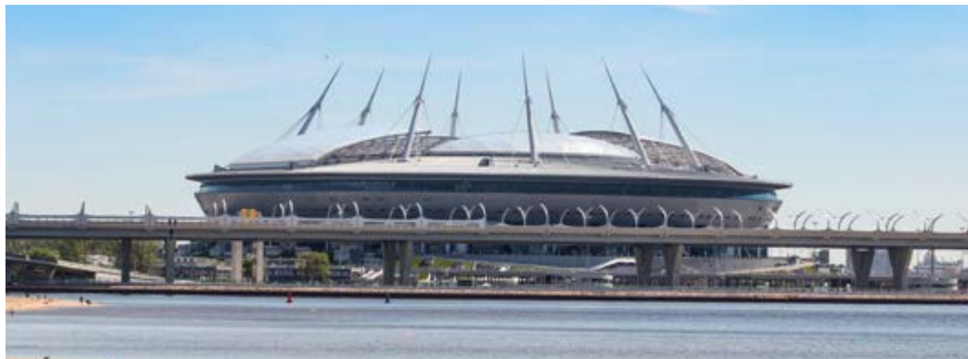
Стадион «Газпром Арена», поставка металлоконструкций 12 600 т, г. Санкт-Петербург
