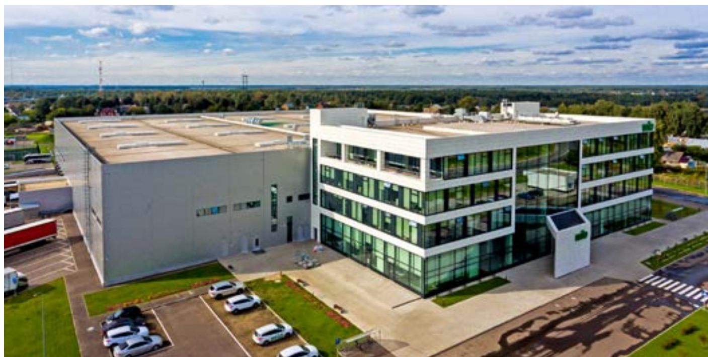
Производственно-складской корпус, площадь 17 500 м 2 , Московская обл.
