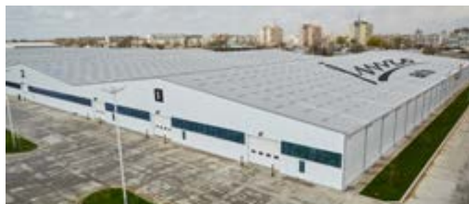
Фабрика оконных конструкций, площадь 76 тыс. м 2 , Узбекистан
