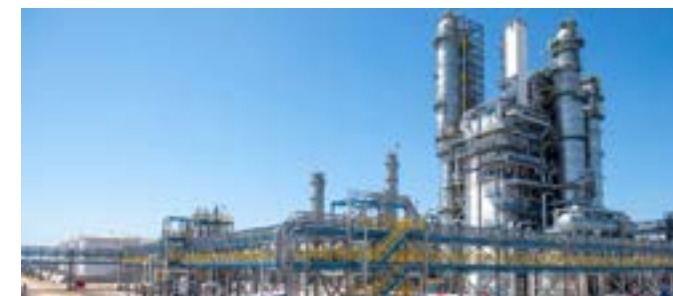
Амурский газоперерабатывающий завод (АГПЗ), вес МК 375 т, Амурская обл.
