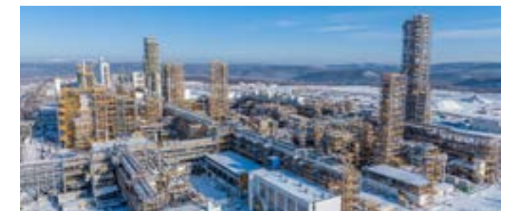
Здание склада и компрессорной станции пиролиза. Вес МК 3600 т., г. Иркутск
