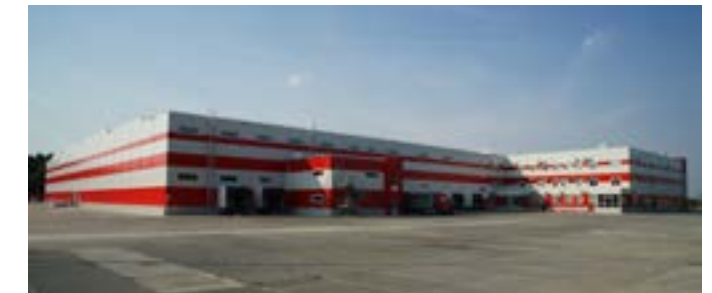
Распределительный центр «Магнит», площадь 19 700 м 2 , Смоленская обл.
