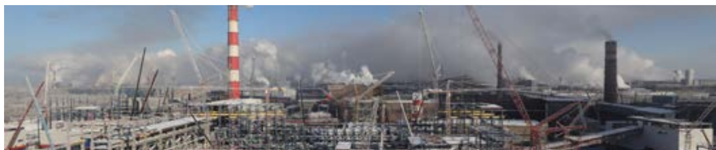
Комплекс цеха по производству окатышей, вес МК 42 000 т, г. Череповец
